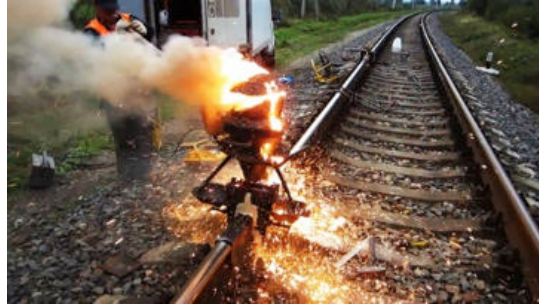
Зураг 3.1.21. Төмөр замын эвдрэл гэмтлийг засварлаж буй байдал
