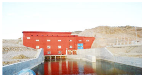
Зураг 6.5. Дөргөний усан цахилгаан станц
